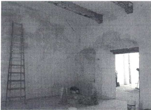
APLANADOS, SELLADOR, PINTURA
