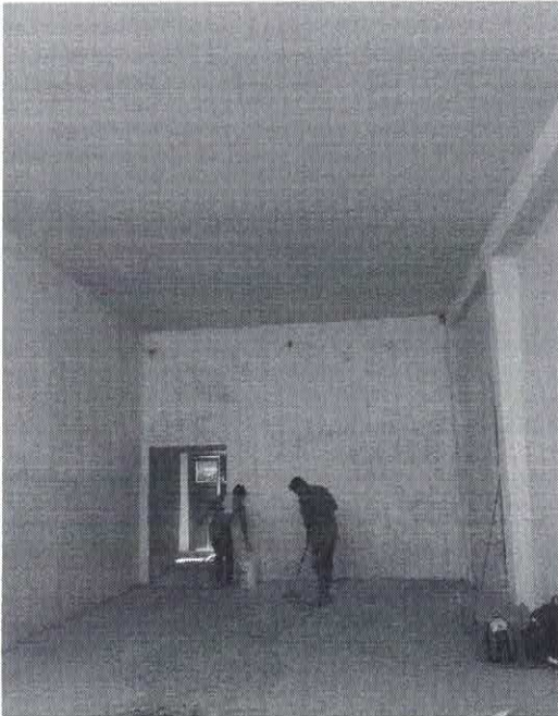
PINTURA Y SELLADOR EN MUROS Y PLAFONES
