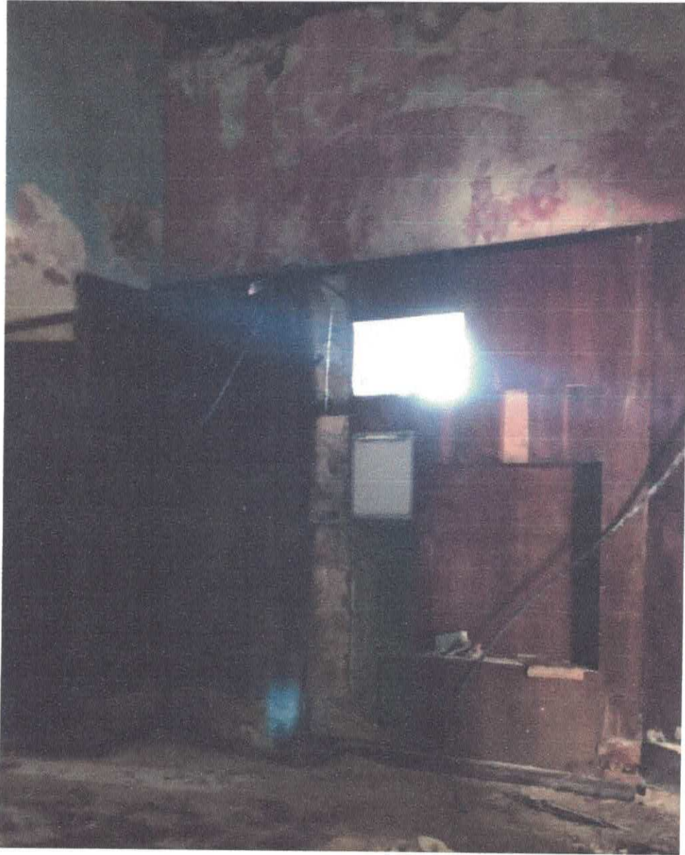
DESMANTELAMIENTO DE MUROS DE CARPINTERIA
