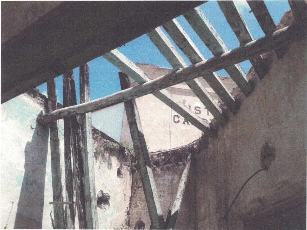
DESMANTELAMIENTO DE VIGAS DE MADERA Y POSTERIOR RECOLOCACIÓN.
