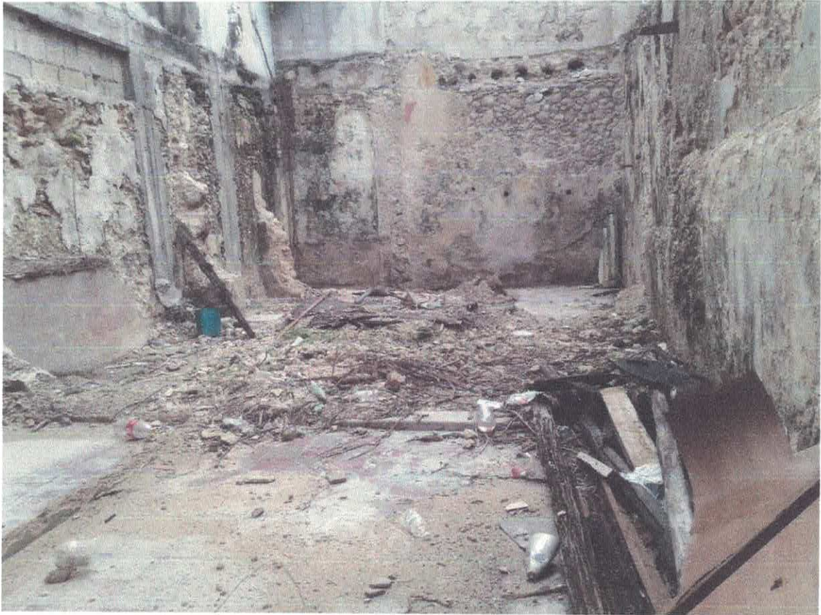
DEMOLICIÓN DE MUROS DE MAMPOSTERIA Y LIMPIEZA DEL PREDIO
