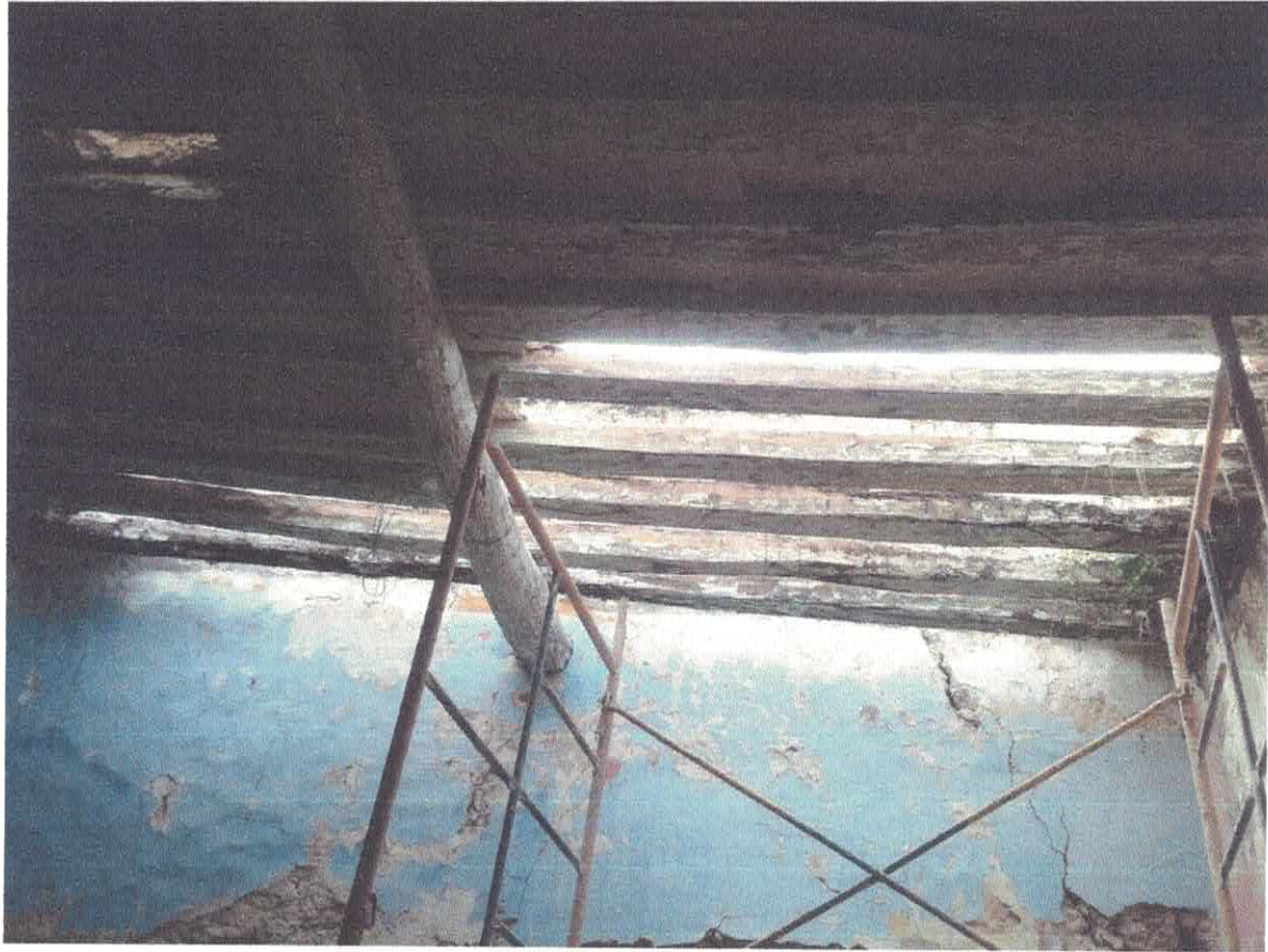
DEMOLICIÓN DE LOSA
