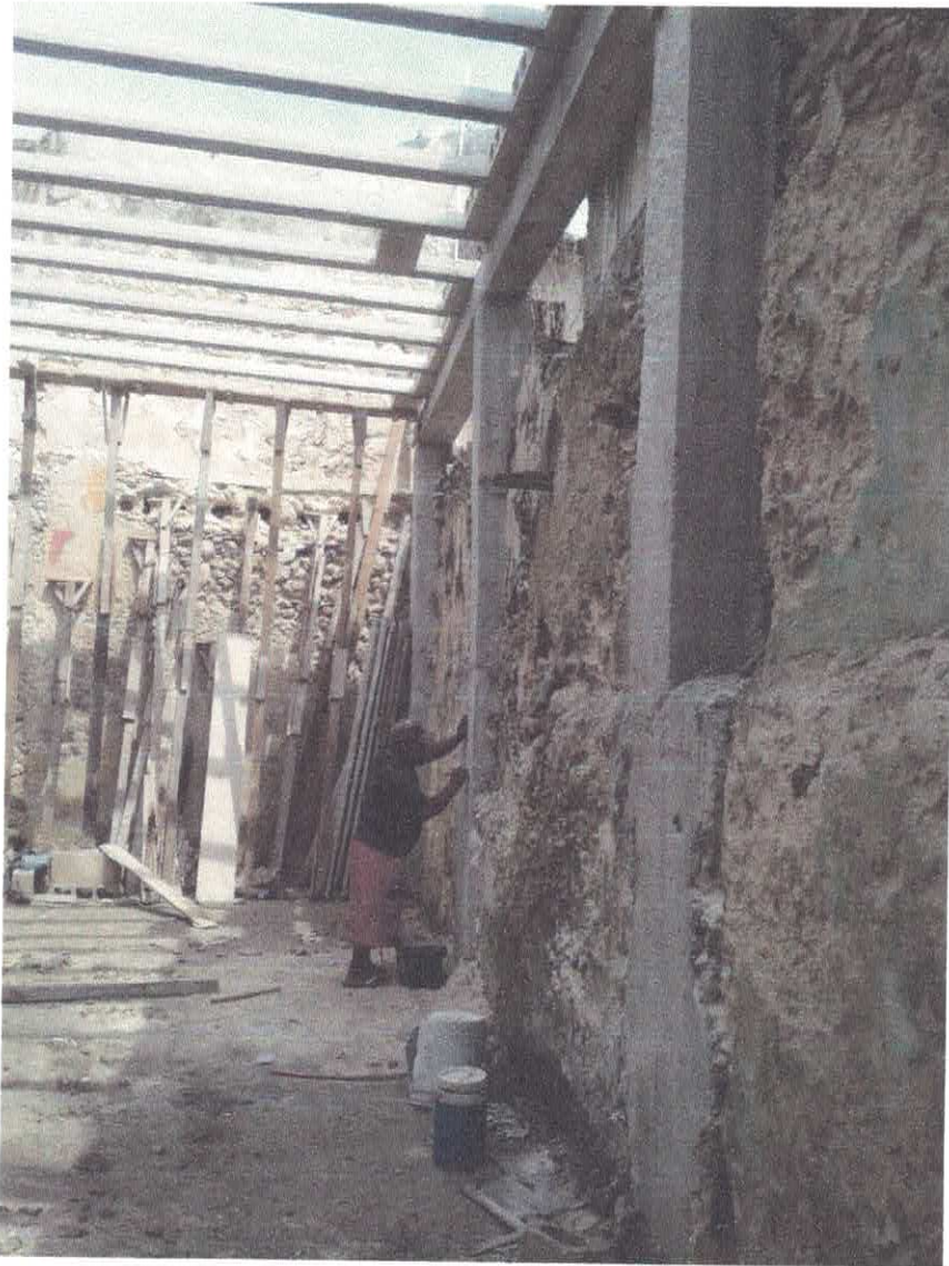
ESTRUCTURA DE CONCRETO PARA RECIBIR LOSA DE VIGUETA Y BOVEDILLA
