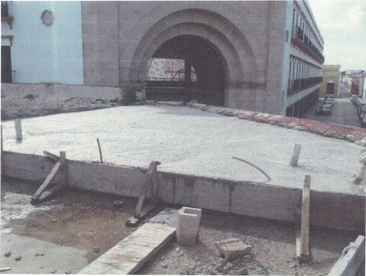
COLADO DE LOSA CON CONCRETO F'C=200KG/CM2
