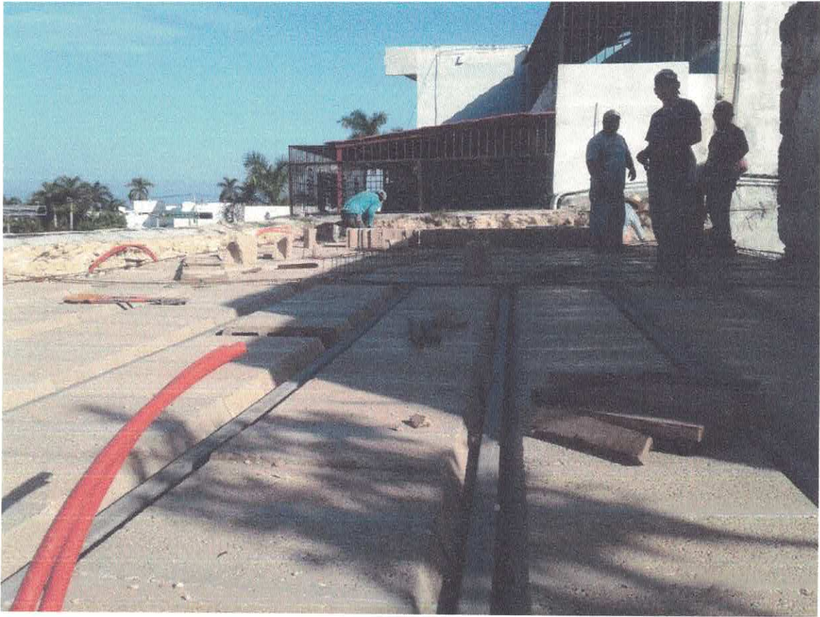
HABILITADO DE ACERO DE REFUERZO EN LOSA Y PREPARACIÓN DE SALIDAS ELÉCTRICAS
