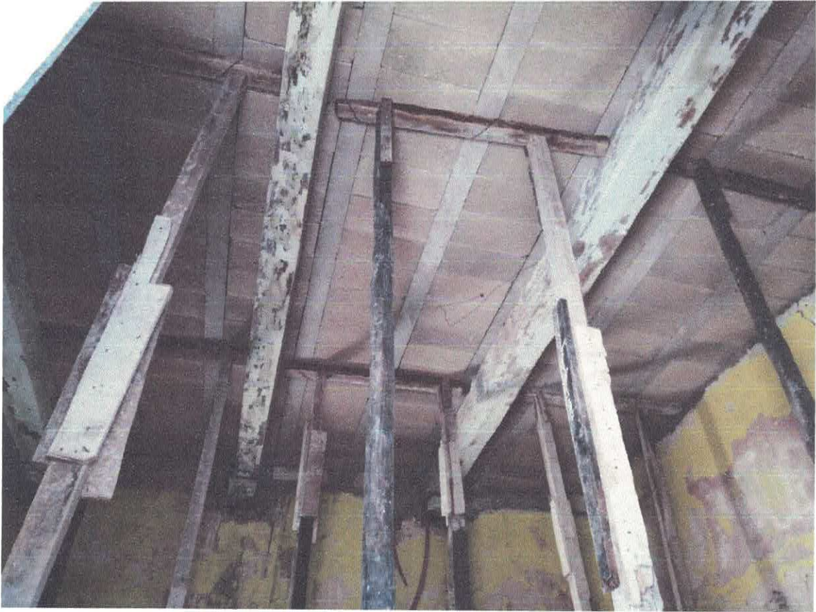
APUNTALAMIENTO DE LOSA DE VIGUETA Y BOVEDILLA
