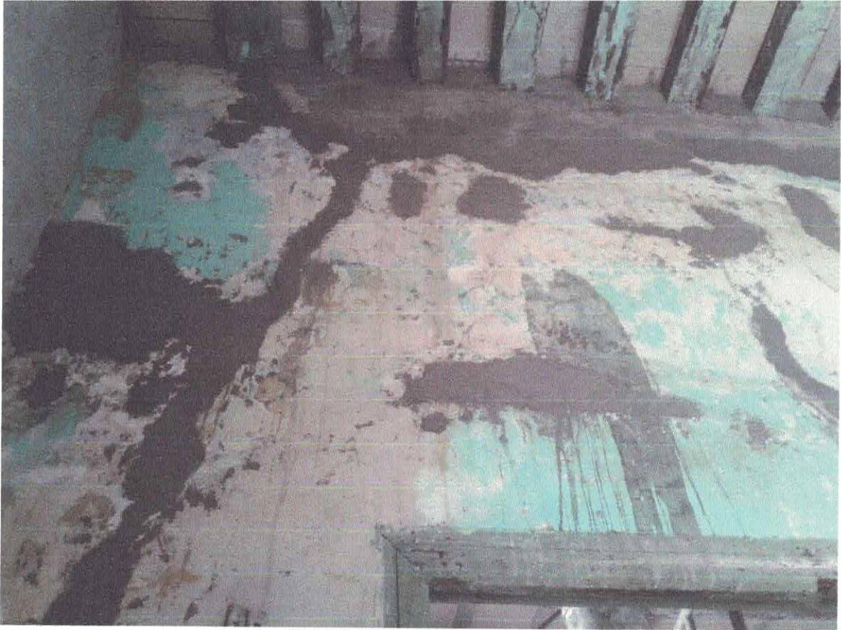
RESANE EN MUROS CON MORTERO
