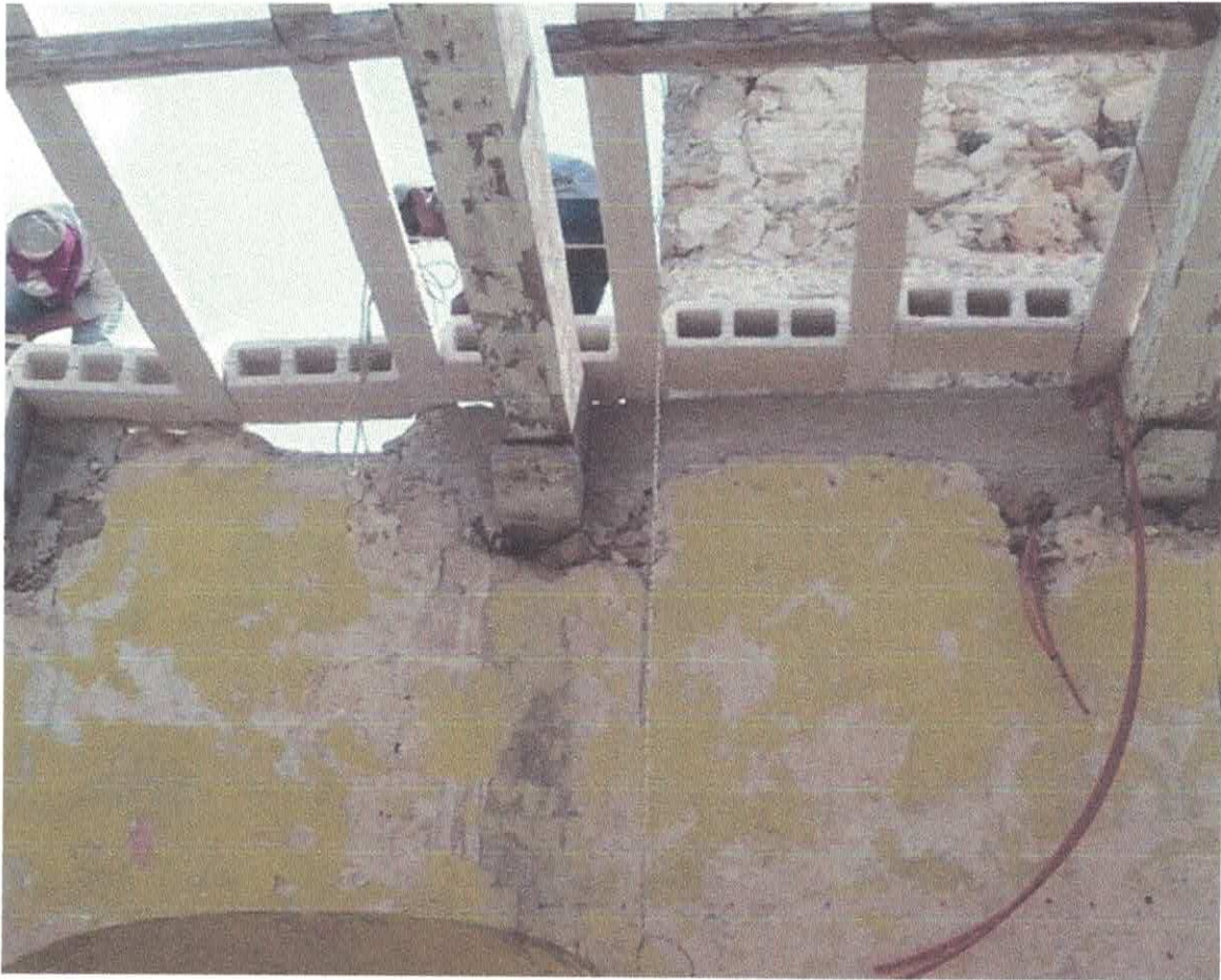
SUMINISTRO Y COLOCACIÓN DE VIGUETA Y BOVEDILLA
